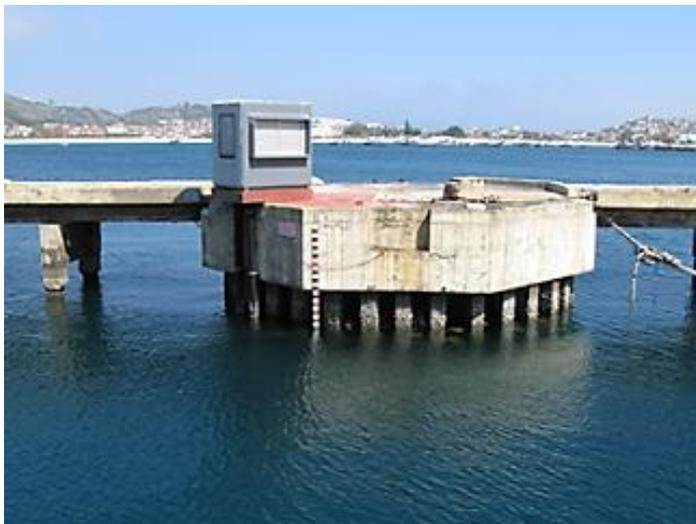
Figura 28: Marégrafo do Porto do Forno. Arquivo IEAPM.
