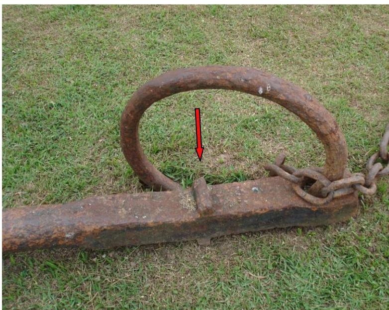
Imagem 130 - Detalhe da parte superior da haste contendo encaixe para cepo de madeira. Pode-se notar também a presença do anete e da amarra de ferro, sem malhetes
