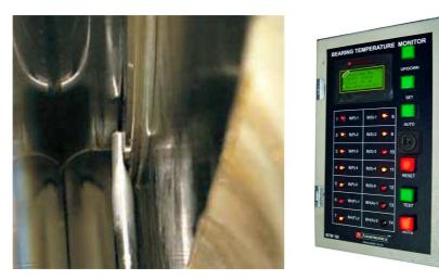
Figura 23 - Monitoramento da temperatura dos mancais do motor
