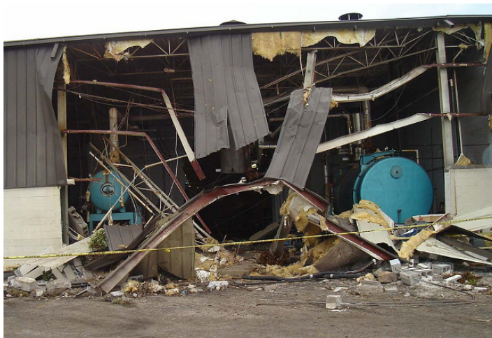
Figura 17: Estrago causado por explosão de uma caldeira.
