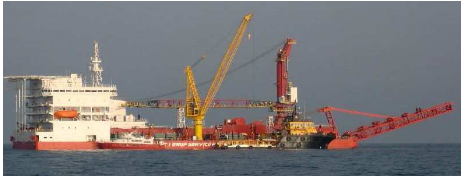
Figura 6 - Balsa de Serviço
