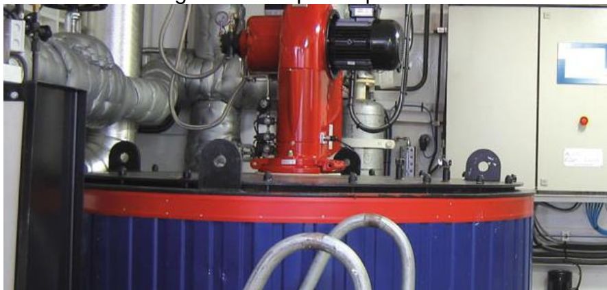
Figura 3 – Corpo do queimador
