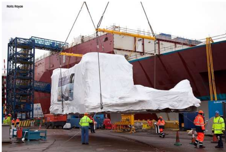
Figura 19 – Turbina Rolls-Royce MT30 sendo instalada em porta aviões Britânico.
