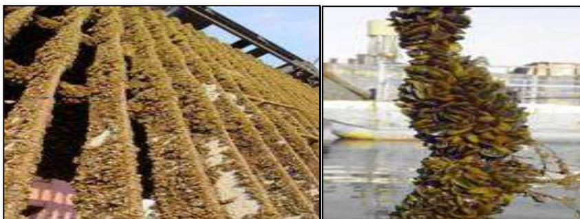
Figs. 14 e15- Incrustação em grade de proteção de hidrelétrica e sobre vegetação submersa. (Crédito das Fotos: Furnas)
