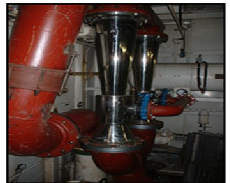
Figuras 4 e 5 – Fotografias dos equipamentos do Sistema de Tratamento de Lastro NEI (Desoxigenação)
