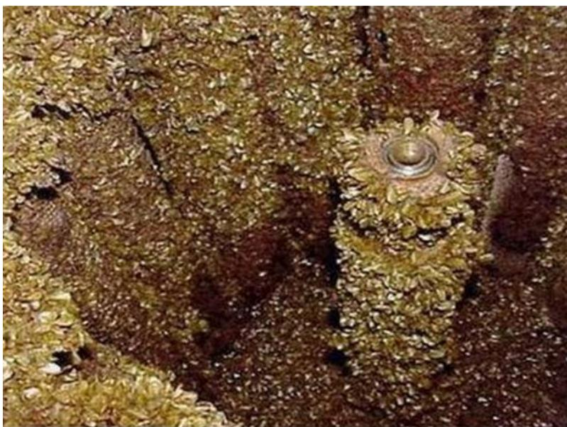
**Figura 9- Equipamento com mexilhões dourados aderidos à superfície (Fonte: [www.3.bp.blogspot.com](http://www.3.bp.blogspot.com))**
