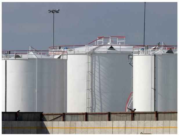
Figura 20: Tanques para recuperação de COV. Fonte: www.google.com
