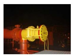
Figura 15:Tomada para conexão da rede retorno de vapores do Terminal. Fonte: Manual de VOC Navion Stavanger.
