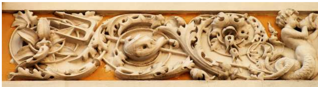
Figura 33 - Fotografia dos elementos decorativos na fachada do prédio do Museu Naval, alusivos ao mar: tridente, concha, Tritão, folhas de acanto em volutas.
