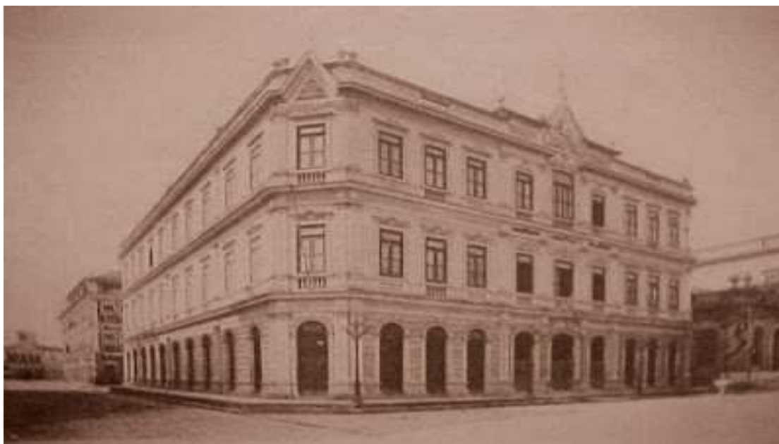
Figura 32 – Imagem da fachada do prédio do Museu Naval (cerca de 1900), de onde pode-se ver que havia um prédio entre ele e a estação hidroviária (ao fundo, à esquerda).
