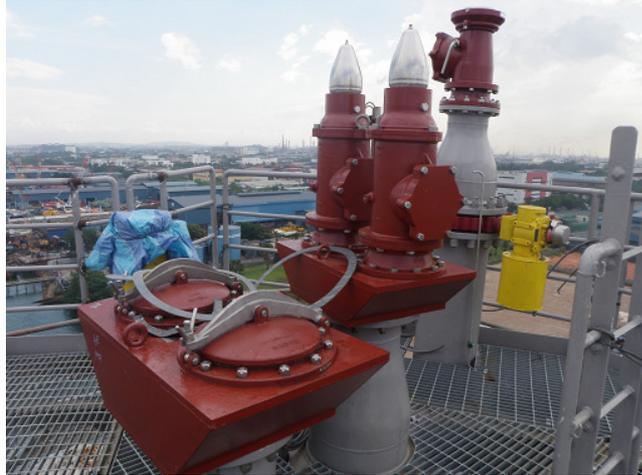
Figura 5.7 Torre de ventilação do Gás Inerte (Acervo pessoal)
