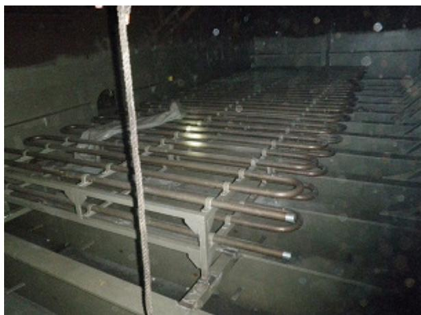
Figura 4.5 – Serpentinas de aquecimento dentro de um tanque de carga (Acervo pessoal).
