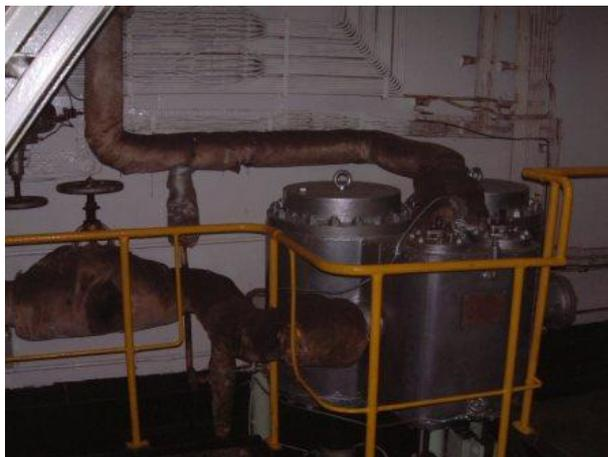
Figura 4.3 – *Stripping pump* (bomba de dreno) original (Acervo pessoal).
