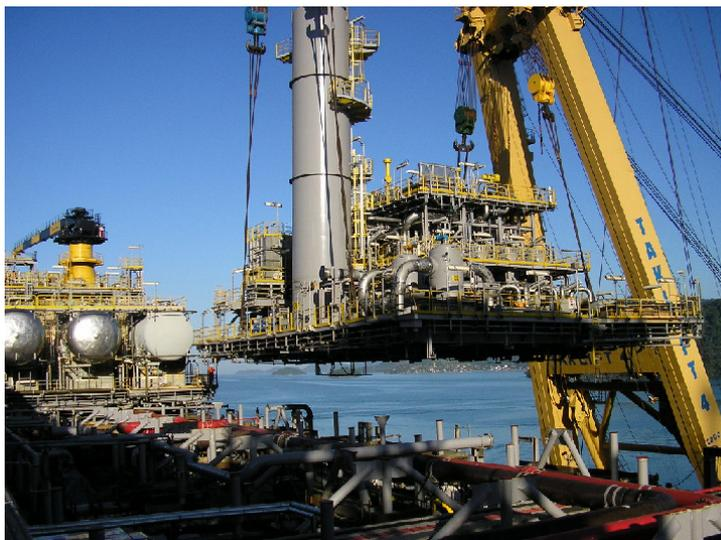
Figura 6.1 – Instalação de um dos módulos de produção (Acervo Pessoal)
