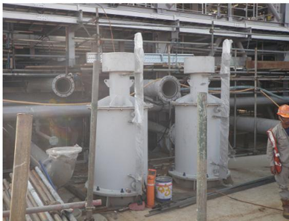
Figura 5.6 – Construção dos novos P/V Breakers (Acervo Pessoal)
