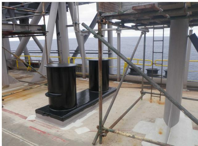
Figura 4.1 – Suporte para os módulos de produção instalados no convés (acervo pessoal)
