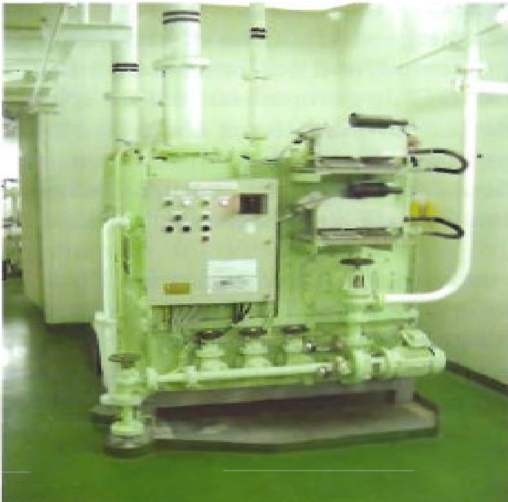
Figura 11: Planta para Tratamento de esgoto em navios mercantes.
