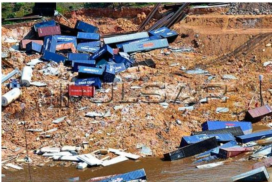
Figura 11 – Deslizamento de terra no pátio de contêineres situado às margens do Rio Negro.
