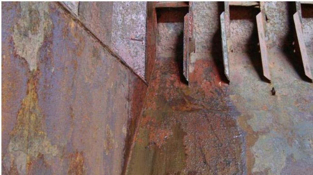
**Figura 7 – Vazamento em porão de carga que indica indício de trinca**
