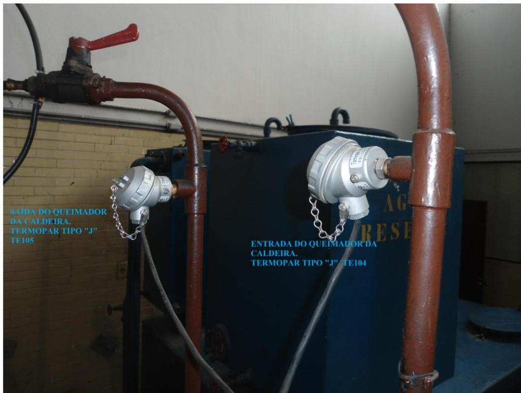
FOTO DE TERMOPAR NO LABORATÓRIO DA CALDEIRA DO CIAGA
