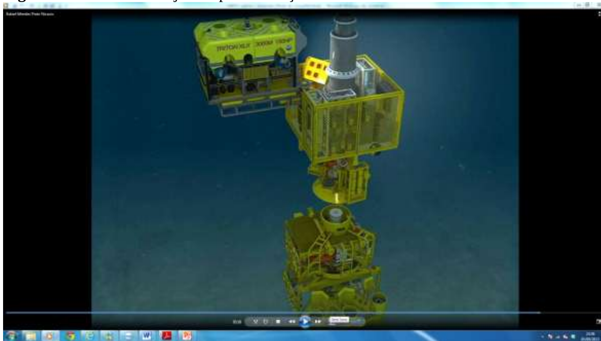
Figura 14: Subida do conjunto após instalação da árvore de natal
