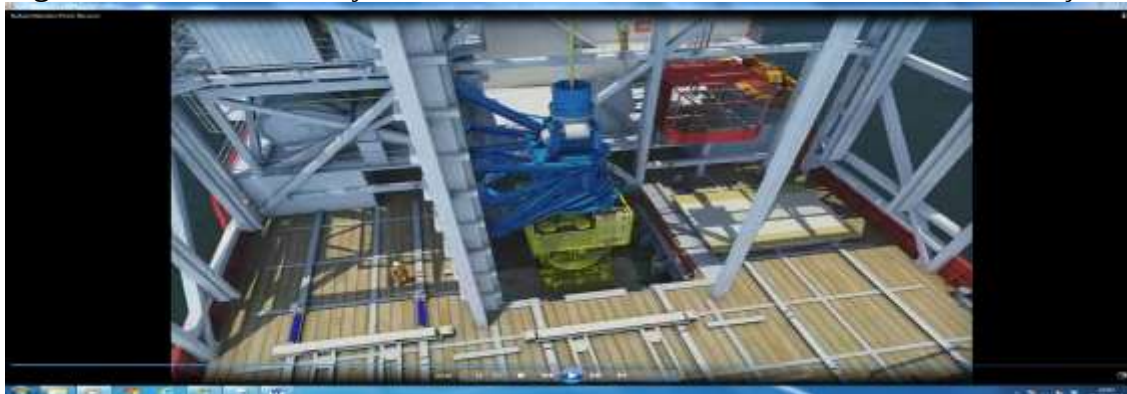
Figura 12: Descida do conjunto SOES e árvore de natal através da torre de instalação
