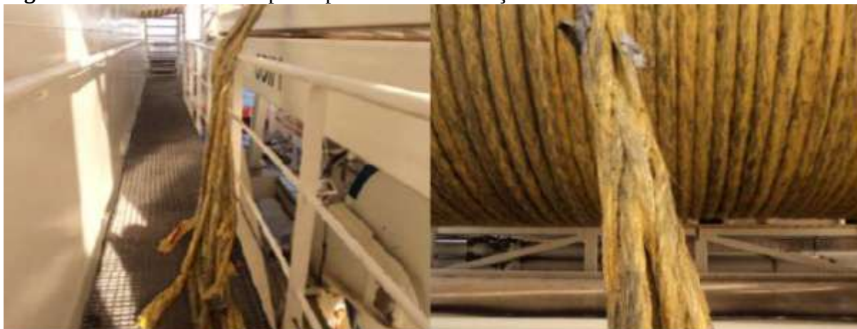
Figura 10: Estado do cabo após ruptura total das tranças
