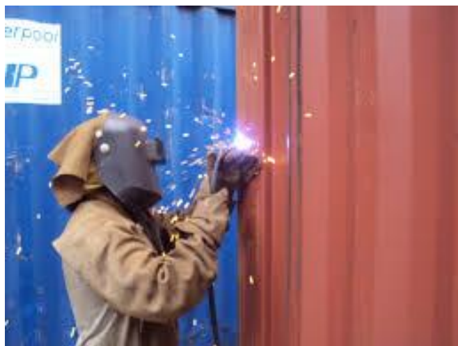
Figura 5: Reparo de contêiner
