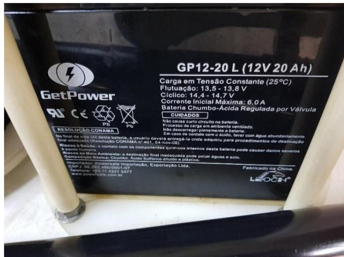
**Figura 31: Bateria 12V GetPower, GP 12 20 L.**
