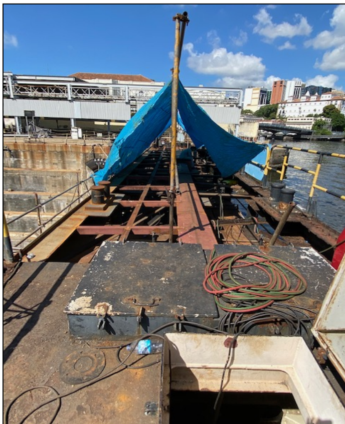
Figura 13: Obra de revitalização da passarela de acesso do Dique Alte. Jardim.
