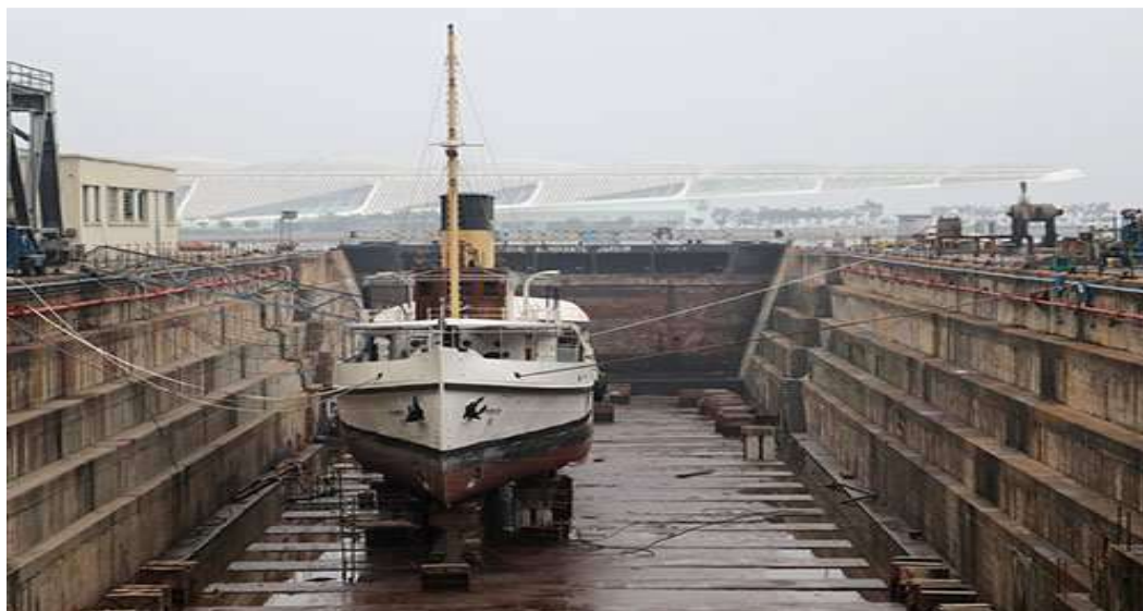
Figura 2: Visão panorâmica do Dique Almirante Jardim durante a docagem do Rebocador Lauindo Pitta.
