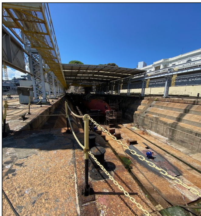
Figura 3: Visão panorâmica do Dique Santa Cruz durante a docagem do S. Tikuna.
