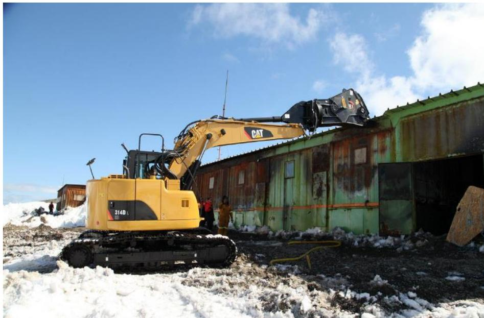
FIGURA 4 – Tesoura hidráulica
