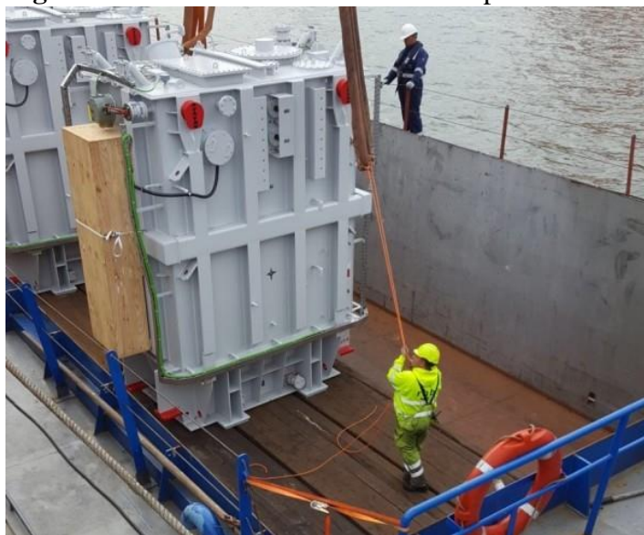
Figura 15: Transformadores sendo transportados
