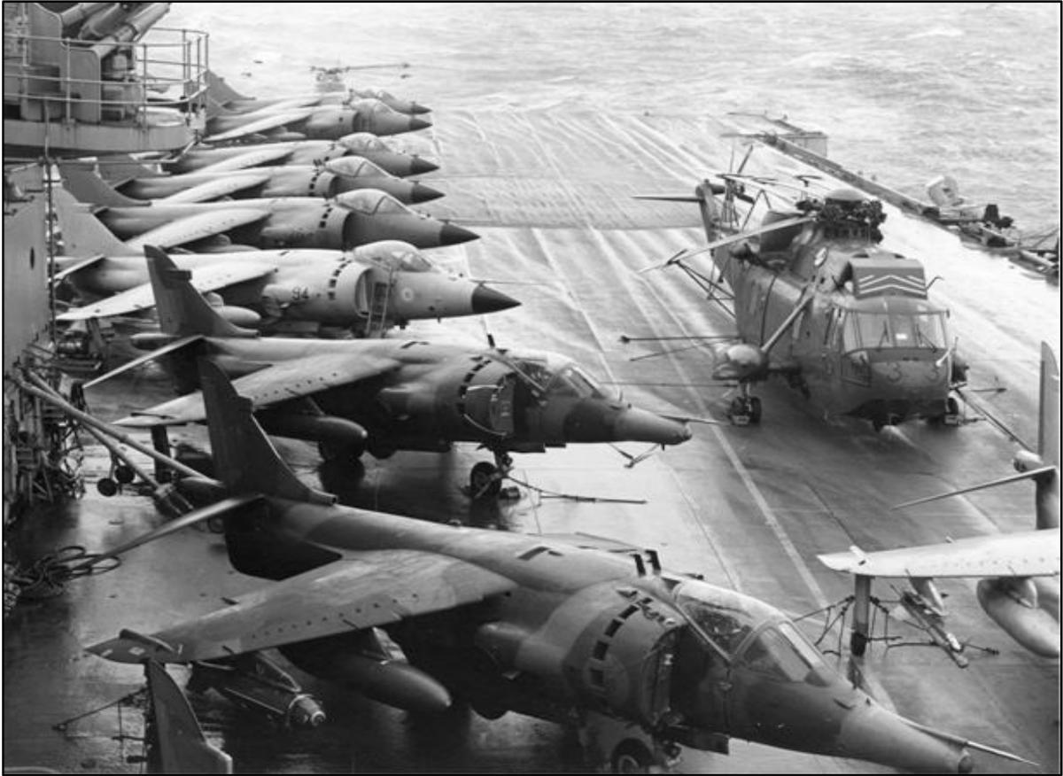
FIGURA 4 – Três *Harriers GR.3* do Esquadrão N° 1 da *Royal Air Force* e seis *Sea Harrier FRS.1* (ao fundo), a bordo do *HMS Hermes*, acompanhados de um helicóptero antissubmarino *Westland Sea King HAS.5*, pertencente ao Esquadrão 820 da *Royal Navy*. Na foto pode-se observar a diferença de desenho entre as aeronaves *Harrier*, notadamente na parte de vante (*cockpit* e nariz dos aviões)
