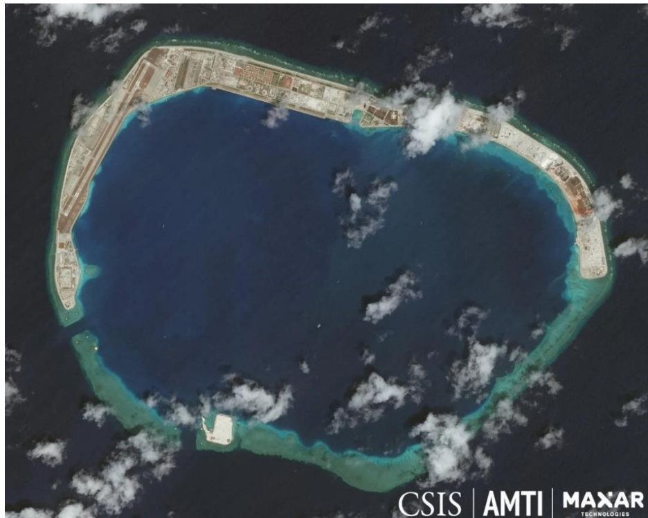
Figura 5 – Construção de aeródromo e militarização do Recife Mischief , no MSC. Fonte: AMTI, 2022.
