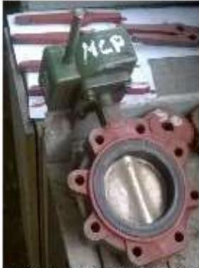
Figura 02 – VV de aspiração do MCP.
