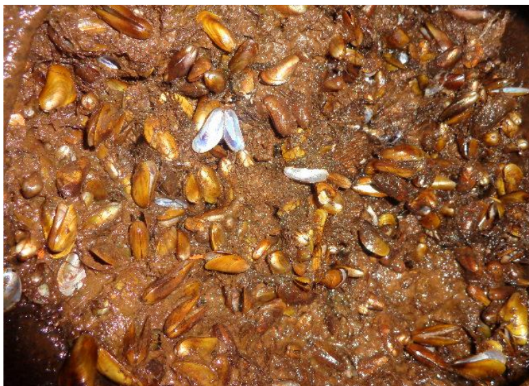
FIGURA 42 - MEXILHÃO NO FILTRO DO SISTEMA DE RESFRIAMENTO DA USINA
