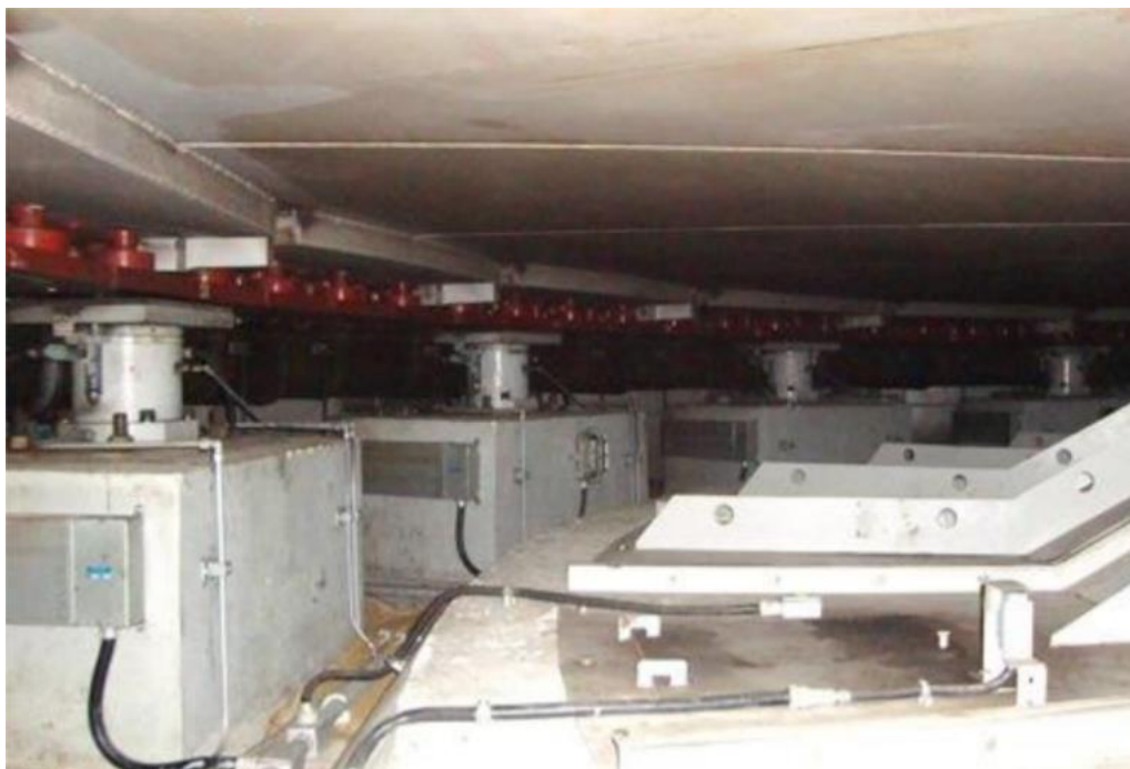
FIGURA 36 - AMBIENTE DO SISTEMA DE FRENAGEM, SOB O ROTOR DO GERADOR.
