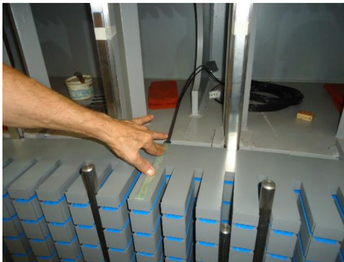
FIGURA 58 - SENSOR RTD SENDO INSTALADO NO NÚCLEO DO ESTATOR DO GERADOR.
