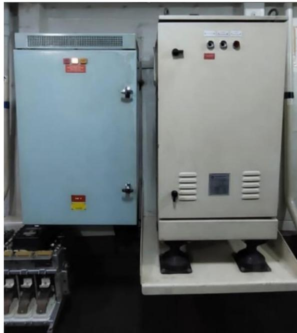
O cubículo de controle mestre processa o sinal enviado pelo eletrodo de referência com a voltagem de referência, que é um potencial gerado no próprio circuito de controle ajustado por um potenciômetro e mantido em um valor de 800 mV (DEnsM, 1977).
