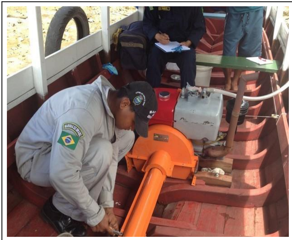
FOTO 4 - Militar da CPAOR instalando a proteção
