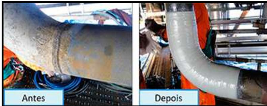
Figura 1.1 – Proteção com reforço estrutural no duto, CONTINENTALMAQUINAS (2020).
